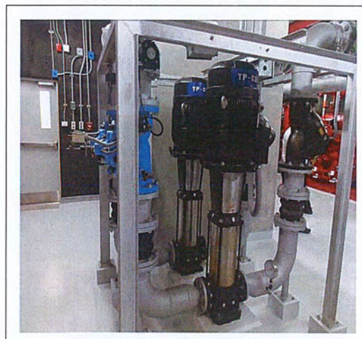
เครื่องสูบน้ำ (Transfer Pump)
