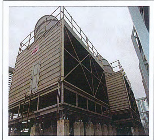
ลักษณะการติดตั้ง Cooling Tower
